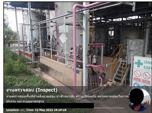
รูปที่ 2-20 กำแพงล้อมรอบถังเก็บสารเคมี
