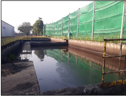
รูปที่ 2-11 บ่อตกตะกอน และบ่อดักไขมัน บริเวณปลายรางระบายน้ำทิ้ง
