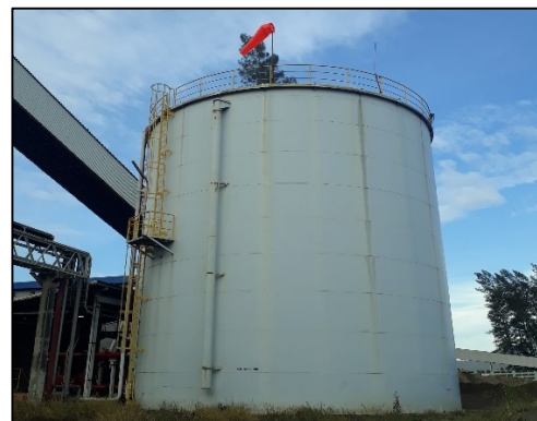
รูปที่ 2-22 ถังเก็บน้ำสำรองดับเพลิง ขนาด 4,000 m 3
