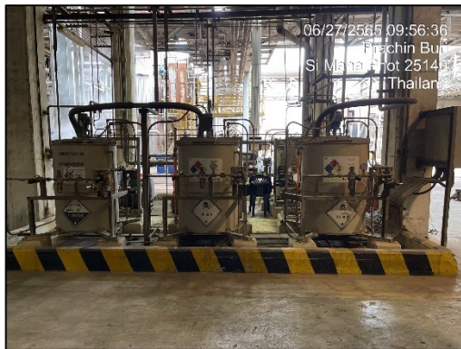
รูปที่ 2-20 กำแพงล้อมรอบถังเก็บสารเคมี
