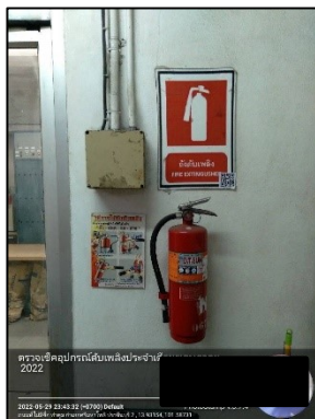
รูปที่ 2-23 ถังดับเพลิงประเภทผงเคมีแห้ง
